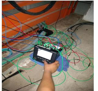
Figura 16 - Instalação do Analisador PowerLogic® ION7650
