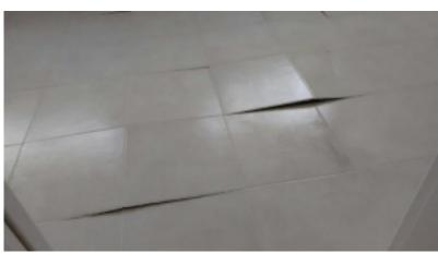
Figura 2 - Desplacamento do piso cerâmico
