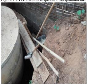
Figura 15: Ferramentas dispostas inadequadamente.
