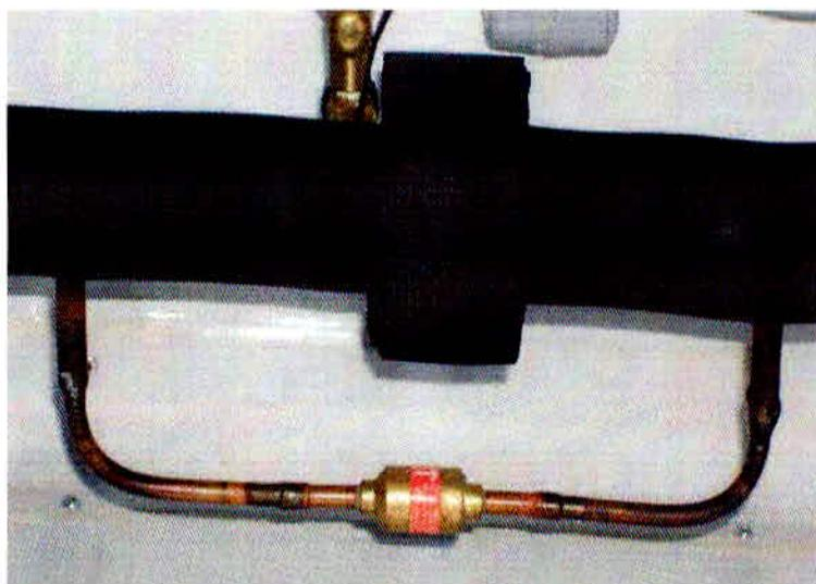
Figura 9. Válvula de alívio e uma válvula de bloqueio CO<sub>2</sub>
