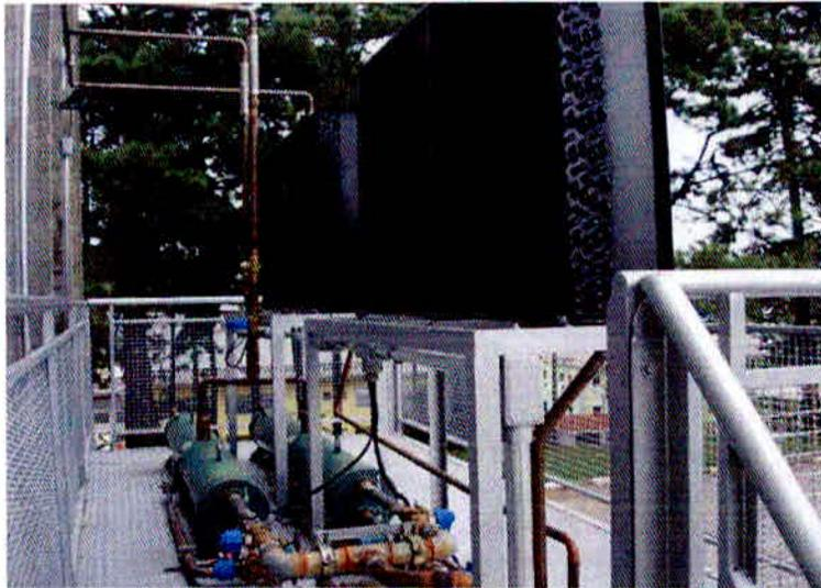
Figura7. Condensador de CO<sub>2</sub>
