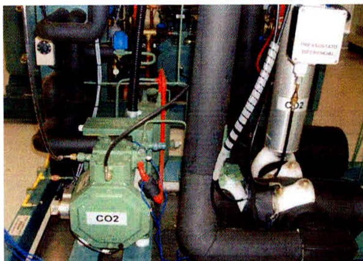
Figura 6. Compressor de CO<sub>2</sub>
