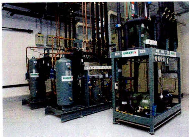
Fig. 5. Detalhe dos racks no centro de treinamento e tecnológico de CO<sub>2</sub> Alemanha
