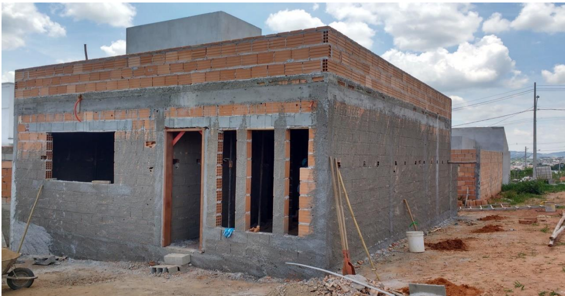
Figura 05 – Método convencional de alvenaria e concreto armado
