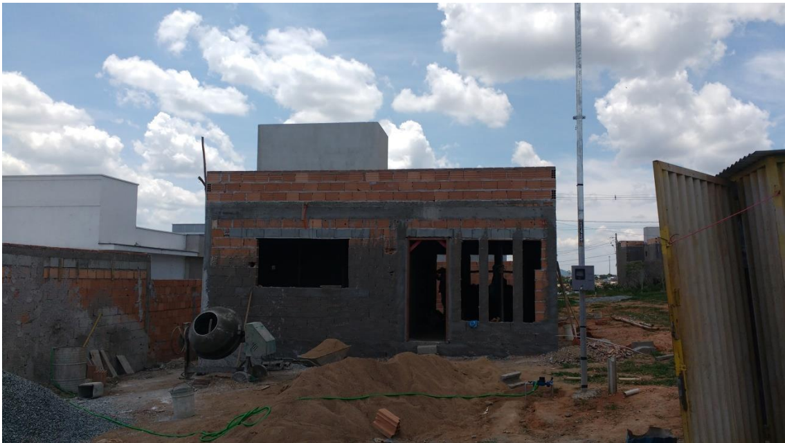
Figura 03 – construção sem canteiro de obra
