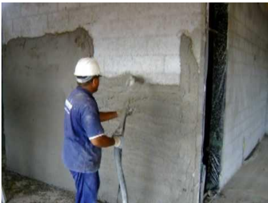
Figura 01 – Uso do projetor de argamassa
