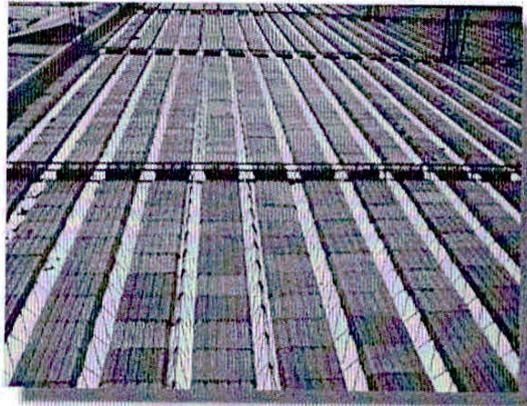
Figura 3 - Laje nervurada pré-moldada.
