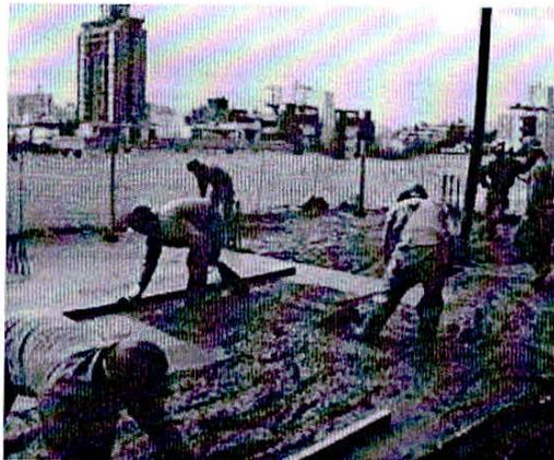
Figura 4 - Concretagem: Laje maciça.
